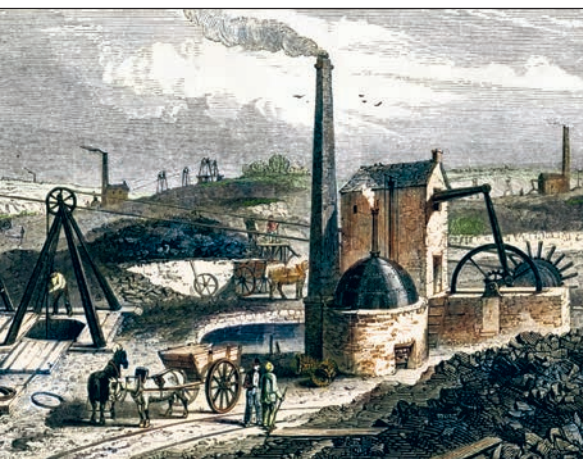
Використання парової машини для добування вугілля. Гравюра 1850 р.
