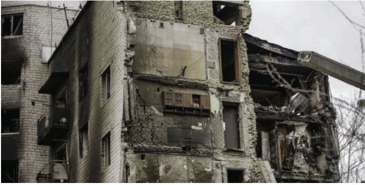
Уцілілі шафка й півник у зруйнованому будинку в м. Бородянці.
