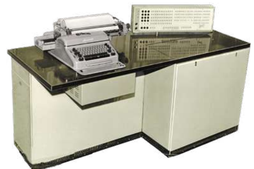
Електронно-обчислювальна машина «МІР» (Машина Інженерних Розрахунків), створена в 1964 р. під керівництвом В. М. Глушкова
