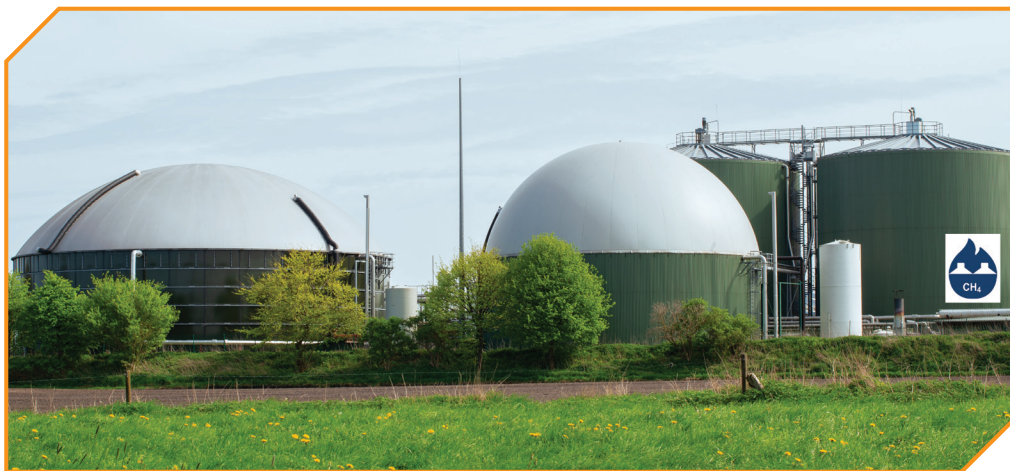
Мал. 45. Установка для отримання біогазу / біометану з біомаси
