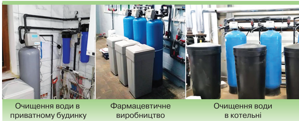
Мал. 37. Приклади використання йонного обміну у підготовці води
