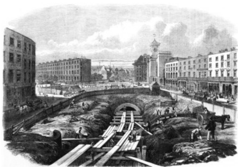
Спорудження Метрополітен-рейлвей (Персі Вільям Джагін, 1861 р.)
