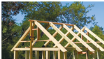
Дерев'яний каркас покрівлі будівлі
