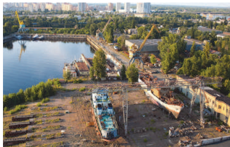
Мал. 127. Суднобудівний завод «Кузня на Рибальському»
