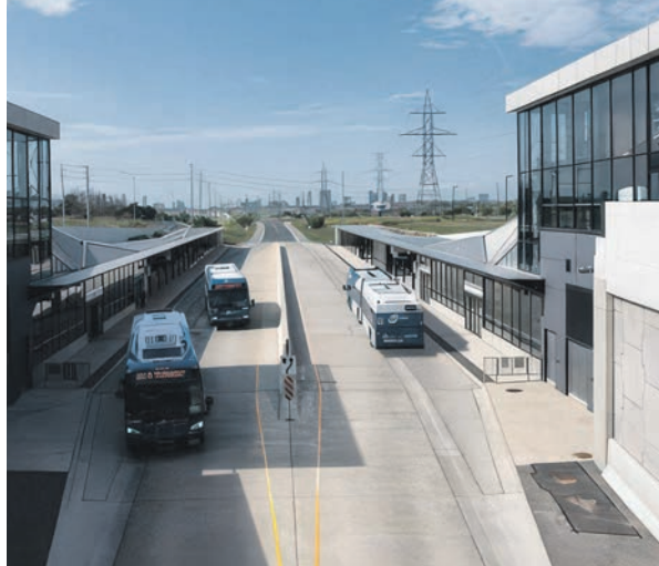
Мал. 4. Підпірні стінки, зупинки та тротуари в місті Міссісага (Канада), зміцнені композитною арматурою, що була виготовлена на підприємстві «Полімерні інноваційні матеріали»
