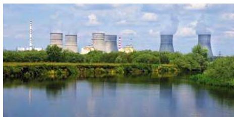
Мал. 15. Атомні електростанції (АЕС) завжди будують біля джерел води через потребу в охолодженні реактора
