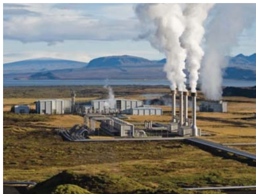
Мал. 33.12. Геотермальна електростанція в Ісландії
