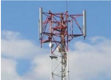
Мал. 18.3. Базова станція стільникового зв'язку
