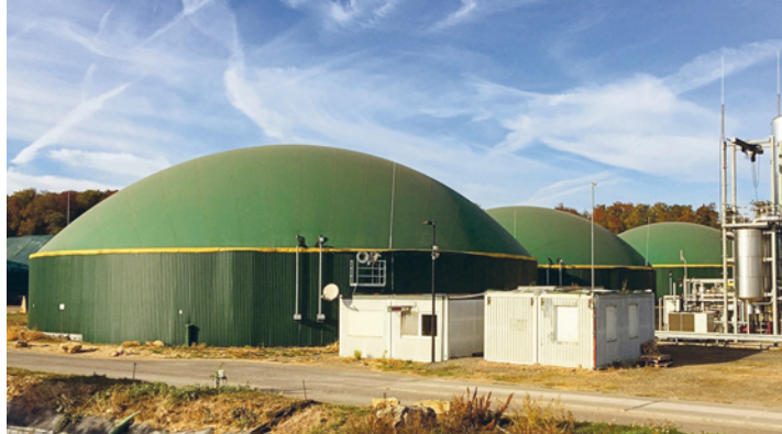
Мал. 33.5. Завод із виробництва біогазу. Метаногенні бактерії розкладають органічні рештки й виділяють біогаз — метан
