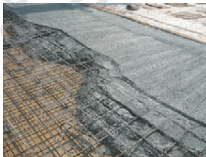
Мал. 30.10. Заливання арматурного каркасу бетоном
