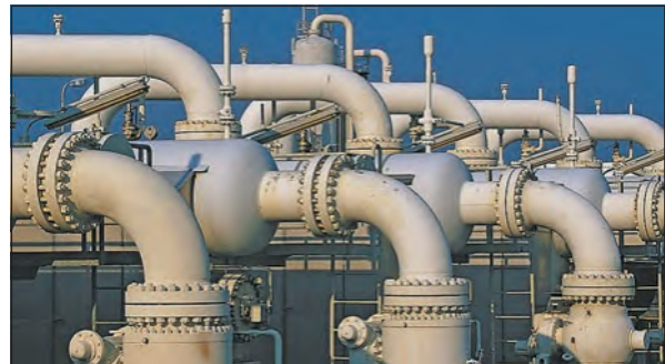
Мал. 2. Магістральний трубопровід.
