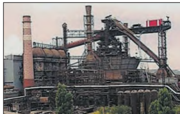
Мал. 3. Металургійний комбінат «Арселор Міттал Кривий Ріг». Підприємства, для яких характерне комбінування різних виробництв, часто називають комбінатами. На них продукція одного виробництва стає сировиною або матеріалом для іншого. Так, до складу металургійного комбінату «Арселор Міттал Кривий Ріг» входять коксохімічне, гірничодобувне і металургійне виробництва.
