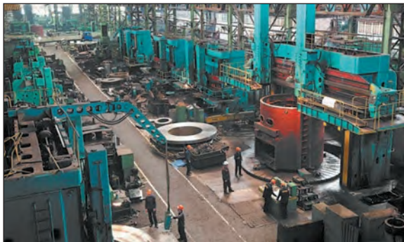
Мал. 1. Державне підприємство «Завод «Електроважмаш» (м. Харків).
