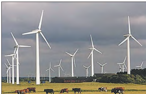
Мал. 4. Ботіївська ВЕС — найбільша вітрова електростанція України, розташована поблизу села Приморський Посад (Запорізька обл.). Завдяки великій протяжності узбережжя, досвіду проектування, будівництва й експлуатації ВЕС, серійному виробництву обладнання та державній підтримці Україна має добрі перспективи використання енергії вітру.
