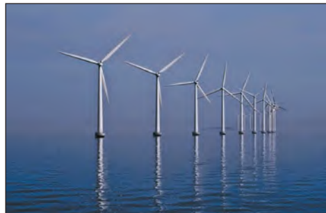
Мал. 2. Шельфова вітрова електростанція Лілгранде (Швеція) має високу ефективність через регулярний морський вітер. Електроенергія передається на землю через підводні кабелі.
