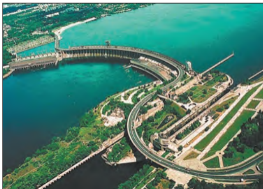
Мал. 3. Дніпровська гідроелектростанція (Дніпрогес) — найстаріша з каскаду ГЕС на річці Дніпро. Розташована в місті Запоріжжі. Для отримання електроенергії тут побудовано греблю, яка перекрила течію річки і підняла рівень води в ній. Вода падає з висоти і змушує обертатися гідрравлічні турбіни, що виробляють електроенергію.
