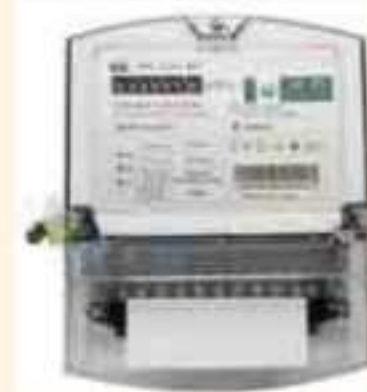
Мал. 149. Електролічильник струму
