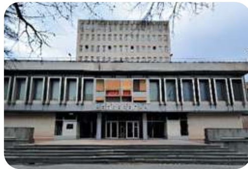
Рис. 7.6. Національний науковий центр «Інститут метрології», м. Харків
