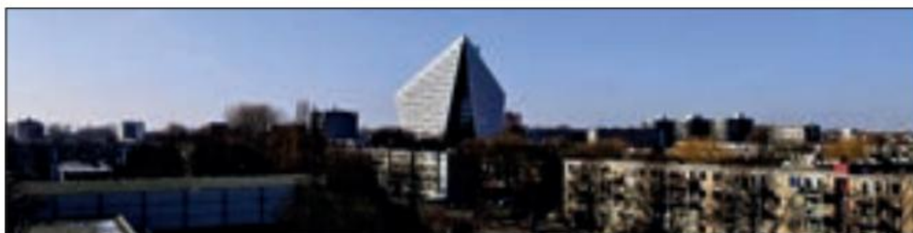
Будівля муніципалітету в Гаазі (Нідерланди). Висота будівлі 72 м. Уведена в експлуатацію у 2011 р. Чотирикутна форма бічних граней із гострим верхнім кутом надає споруді улюблених голландцями обрисів корабля, що здіймається на хвилях. Можливо, на сьогодні це — наймасштабніше втілення в архітектурі різнокутної чотирикутної форми
