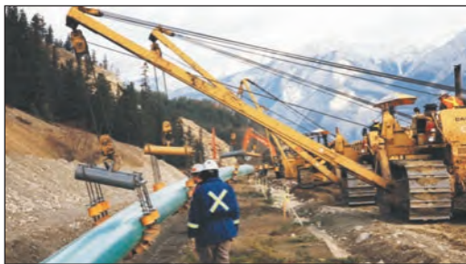
Мал. 1. Спорудження трубопроводу великого діаметра в США.
