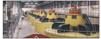
Мал. 1. Турбінний зал ГЕС. Турбіною називають двигун із лопатями, який надає руху валу генератора під тиском пари або води.
