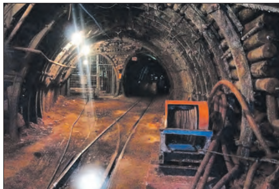
Мал. 2. Шахта «Криворізька» (Дніпропетровська область) — одна з найглибших залізрудних шахт Європи. Роботи ведуть на глибинах 1300—1600 м.
