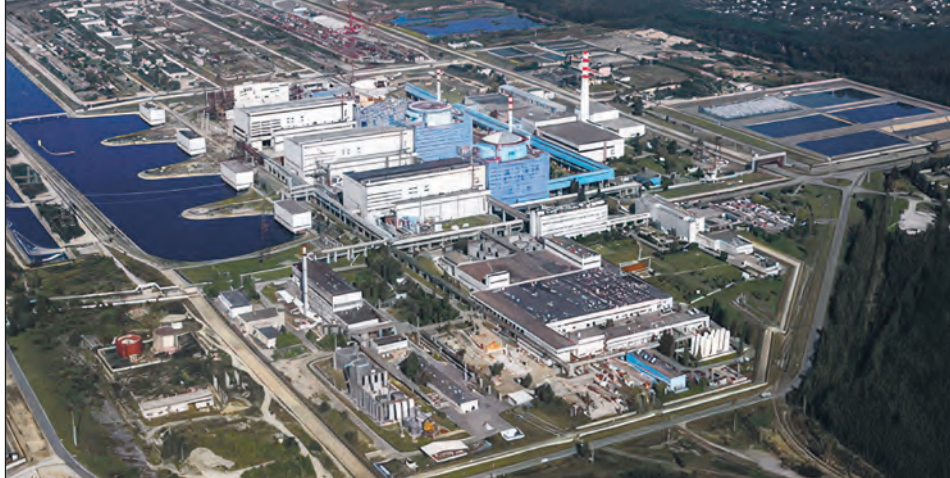
Мал. 3. Хмельницька АЕС. Резервуари води призначені для охолодження конденсаторів турбін атомних реакторів.
