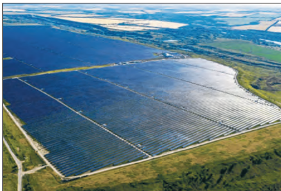
Мал. 4. Нікопольська СЕС потужністю 246 МВт. Вона займає площу понад 400 га та складається з близько 750 тис. панелей.
