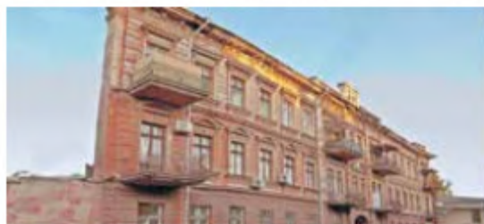
Будинок-стіна в Одесі
