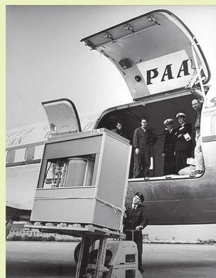
Мал. 3.11. Завантаження IBM 350 Disk File у багажний відсік літака
