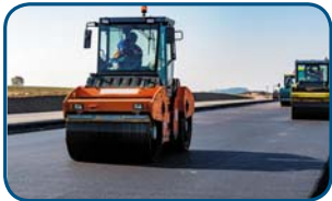
У будівництві доріг
