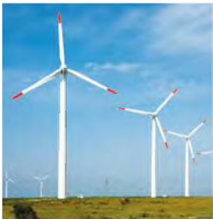
Мал. 145. Вітрова електростанція
