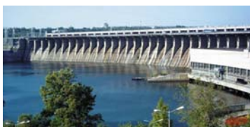
Дніпрогес Дніпровська гідроелектростанція
